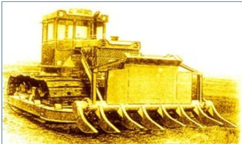
Предназначен для корчевания пней, мелколесья и камней при очистке просек под линии электропередач, трубопроводов и мелиорации земель.
